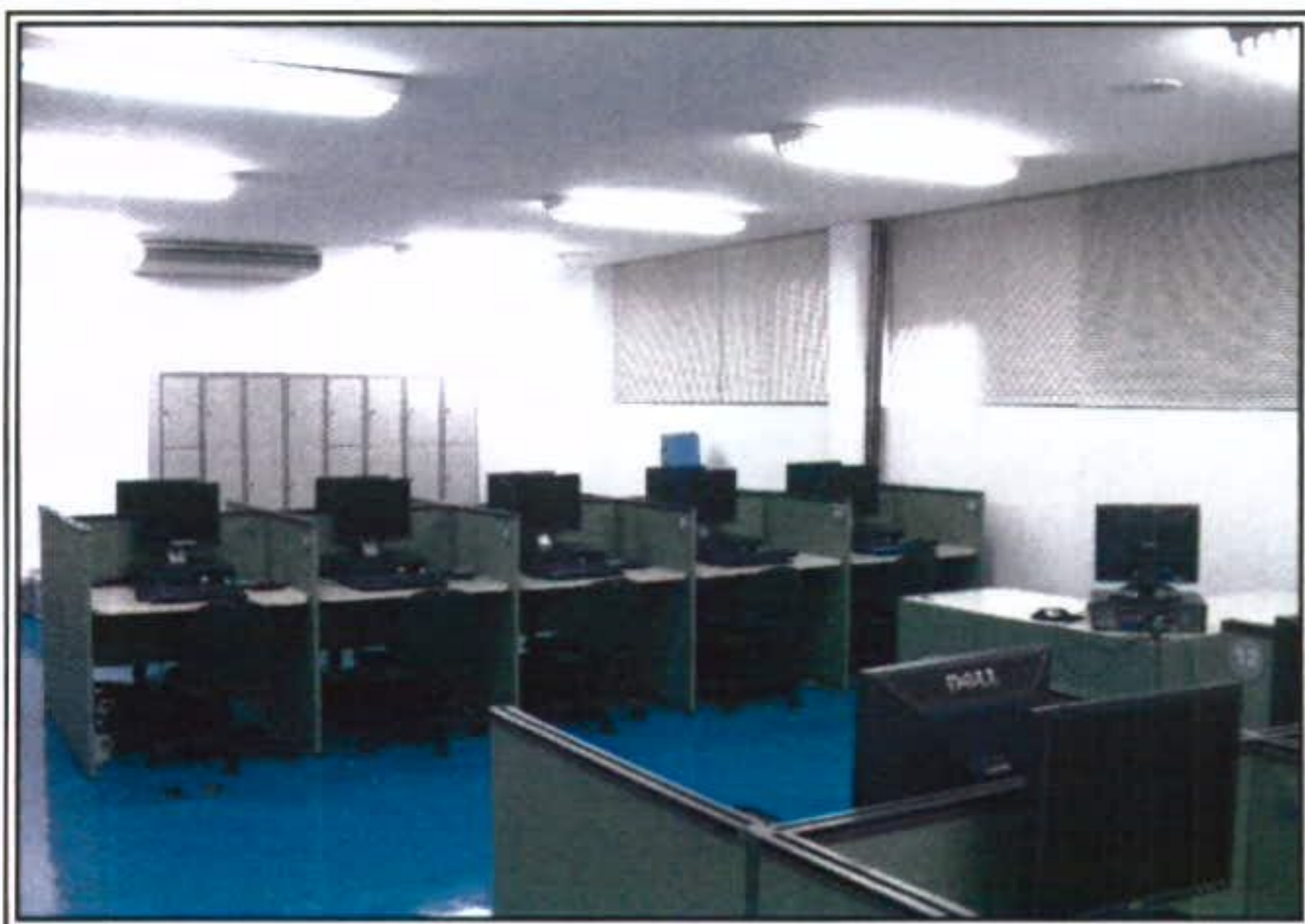
Supervisão/Central de Processamento de Dados
